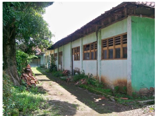
Mess Pegawai Blok Kamis Jln. Trikora / Pengadilan Majalengka Kulon
